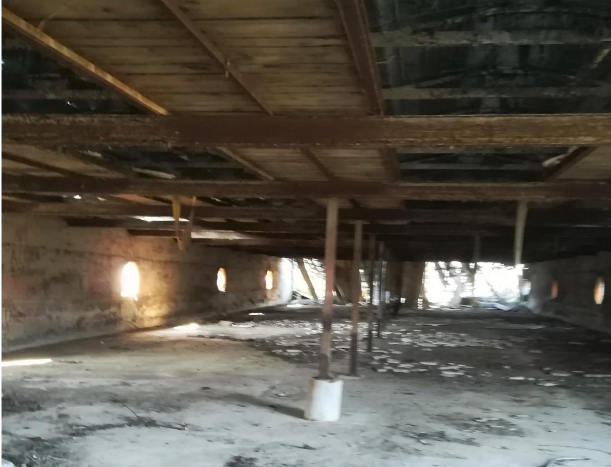
Intérieur d'un des bâtiments
